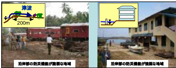
図-4 スマトラ島沖地震による津波被害
