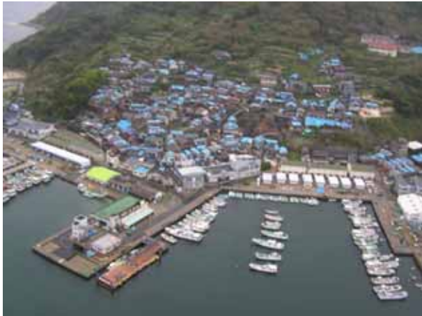
写真-3 玄界漁港と集落（平成17年3月23日）
