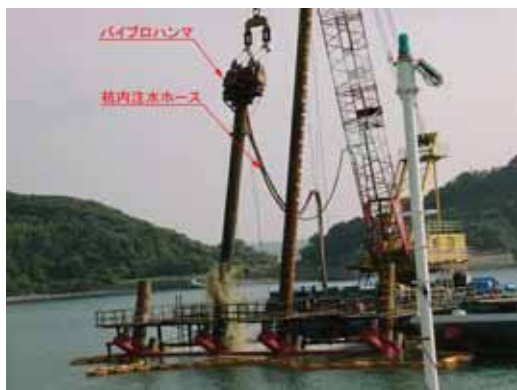
図-4 バイブロハンマーによる鋼管杭の岩盤打設
