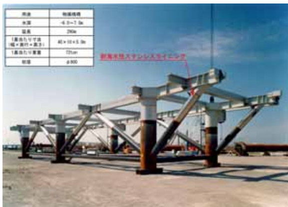
図-5 耐海水性ステンレスライニングによる防食工法
