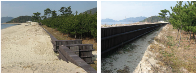
写真-1 虹ヶ浜の擬木柵堤防
