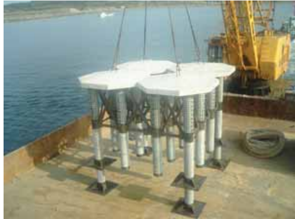
施設沈設風景-1 (10月19日)
