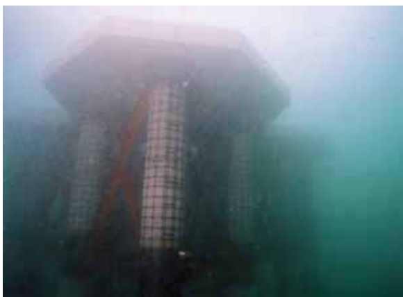
施設沈設風景-2
