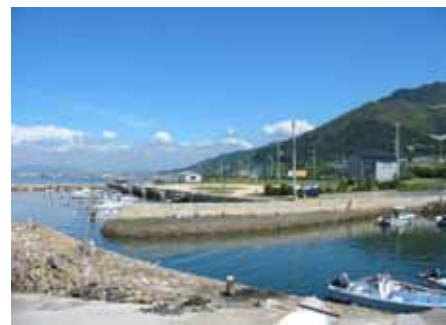
図-1 石積防波堤事例(香川県箕浦漁港)
