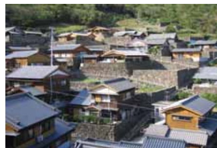
図-2 漁村石垣事例(愛媛県外泊地区)
