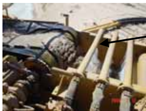
異物除去状況
