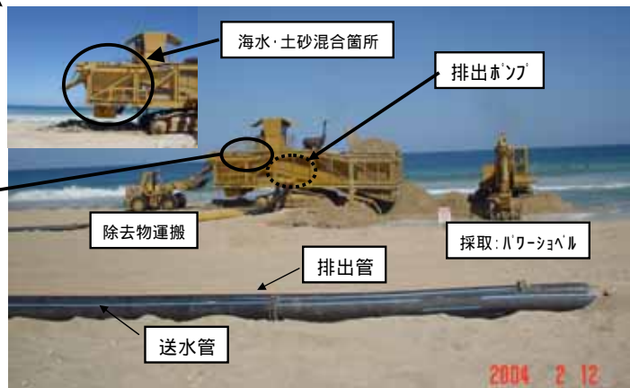
サンドバイパス用施工機械（スラリートラック：移動可）
